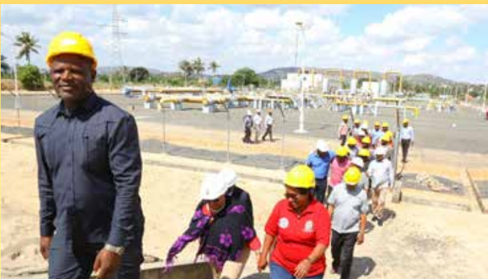
Baadhi ya Wajumbe wa Kamati ya Kudumu ya Bunge ya Hesabu za Serikali wakiwa katika kituo cha kupokea Gesi cha Kinyerezi jijini Dar es Salaam ambacho husambaza Gesi katika maeneo mbalimbali ikiwemo kwenye mitambo inayozalisha umeme ya Kinyerezi I na II.
