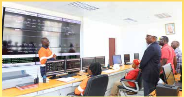
Baadhi ya Wajumbe wa Kamati ya Kudumu ya Bunge ya Hesabu za Serikali wakiwa katika chumba cha kuendesha mitambo katika kituo cha kupokea Gesi cha Kinyerezi jijini Dar es Salaam ambacho husambaza Gesi katika maeneo mbalimbali ikiwemo kwenye mitambo inayozalisha umeme ya Kinyerezi I na II. Wa kwanza kulia ni Mkurugenzi Mtendaji wa TPDC, Dkt. James Mataragio.
